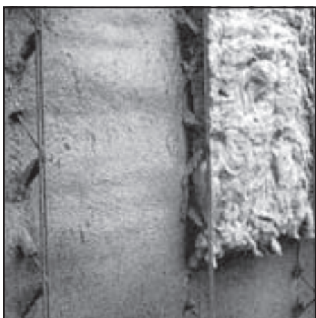
Stucanet® wordt aan beide zijden bespoten
