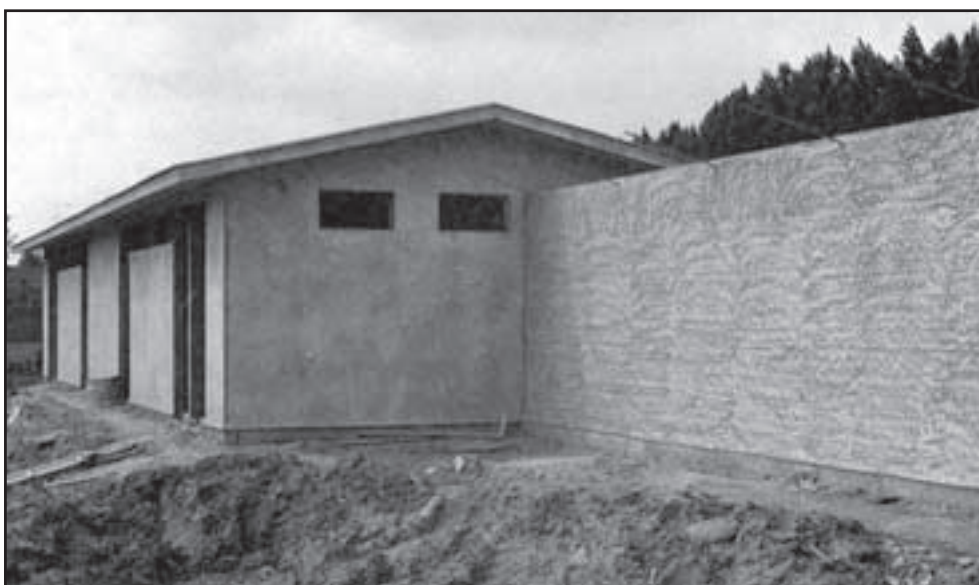
De Stucanet®-panelen worden eerst aan de buitenzijde van de constructie bevestigd. Nadien worden alle voorzieningen in de spouw aangebracht.
