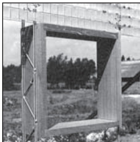
Houten kozijnen: met krammen, of houtschroeven
