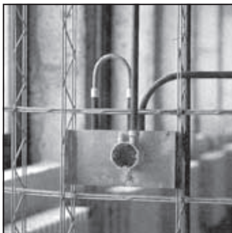
Verzinkt plaatprofiel voor het bevestigen van nutsvoorzieningen.
