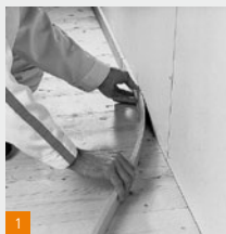
1 Aanbrengen randstrook
