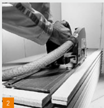
2 Afzagen van liplas voor eerste rij platen
