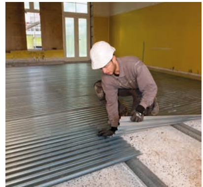
PS-renovatievloer Semi-droog afwerking met zwaluwstaartplaten en beton of gietmortel.
